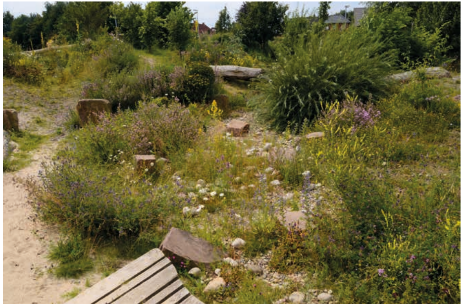
Versickerungsmulde im Kindergarten. In der Astrid-Lindgren-Kita Besenbrück ließ Helmut Hechtbauer das Dachwasser mitten im Spielgelände versickern. Die Mulde wurde mit Wildblumen besät und sieht aus wie ein Spielplatz. Ist es auch.
