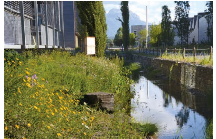
Die Versickerungsmulden des knapp 2 ha großen Außengeländes von Omicron sehen wie gestaltete Naturteiche aus und fügen sich ins naturnahe Gesamtbild ein. Hier wurde eine Seite des 160 m langen Grabens als natürliches Ufer gestaltet und die andere Seite mit einer Trockenmauer aus Hartsandstein akzentuiert.
