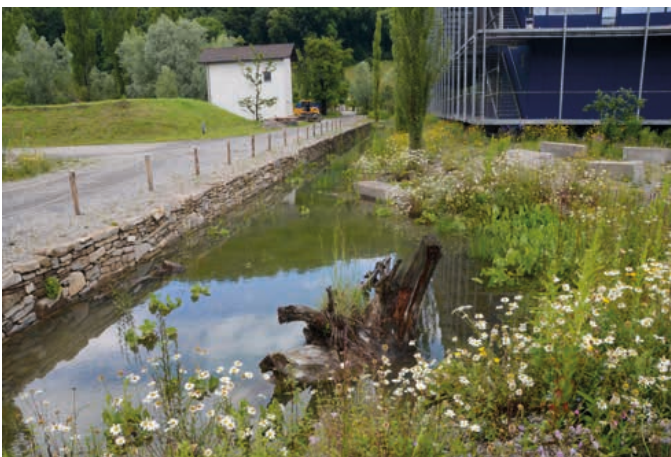
Die Versickerungsmulden des knapp 2 ha großen Außengeländes von Omicron sehen wie gestaltete Naturteiche aus und fügen sich ins naturnahe Gesamtbild ein. Hier wurde eine Seite des 160 m langen Grabens als natürliches Ufer gestaltet und die andere Seite mit einer Trockenmauer aus Hartsandstein akzentuiert.
